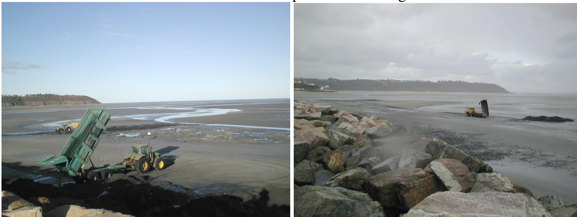
Zone de dépôt derrière la digue
